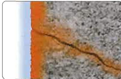
▲散水後、クラック内でコンクリートと反応
