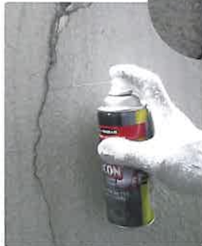
ラドコンジェット注入中
