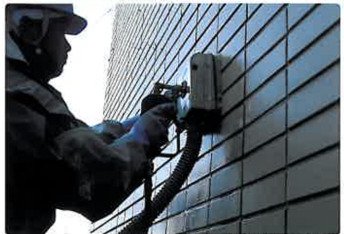
▲「ジェット&バキューム工法」で飛散防止も徹底します。
