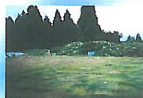
ゴルフ場芝回復工事
