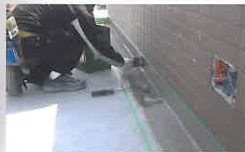
打継ぎ塗膜処理
