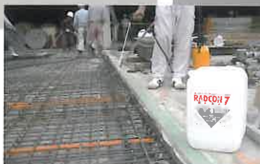
コンクリート床 打継ぎ処理
