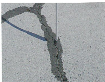
① ひび割れ充填
