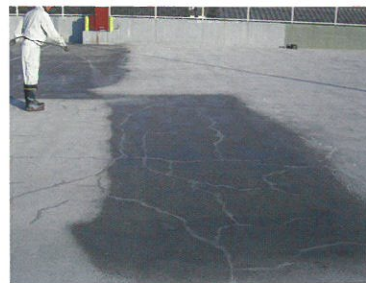
③ 施工面全体への塗布
