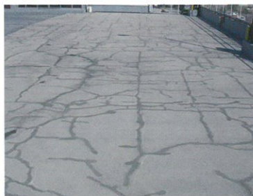
② ひび割れ充填完了
